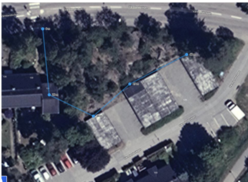
Grävning Axelsö ca 70 m
